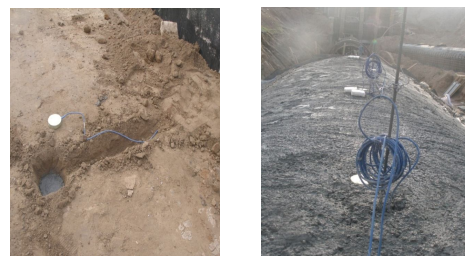
(a) 暗道侧部土压力盒埋设 (b) 暗道顶部土压力盒埋设
